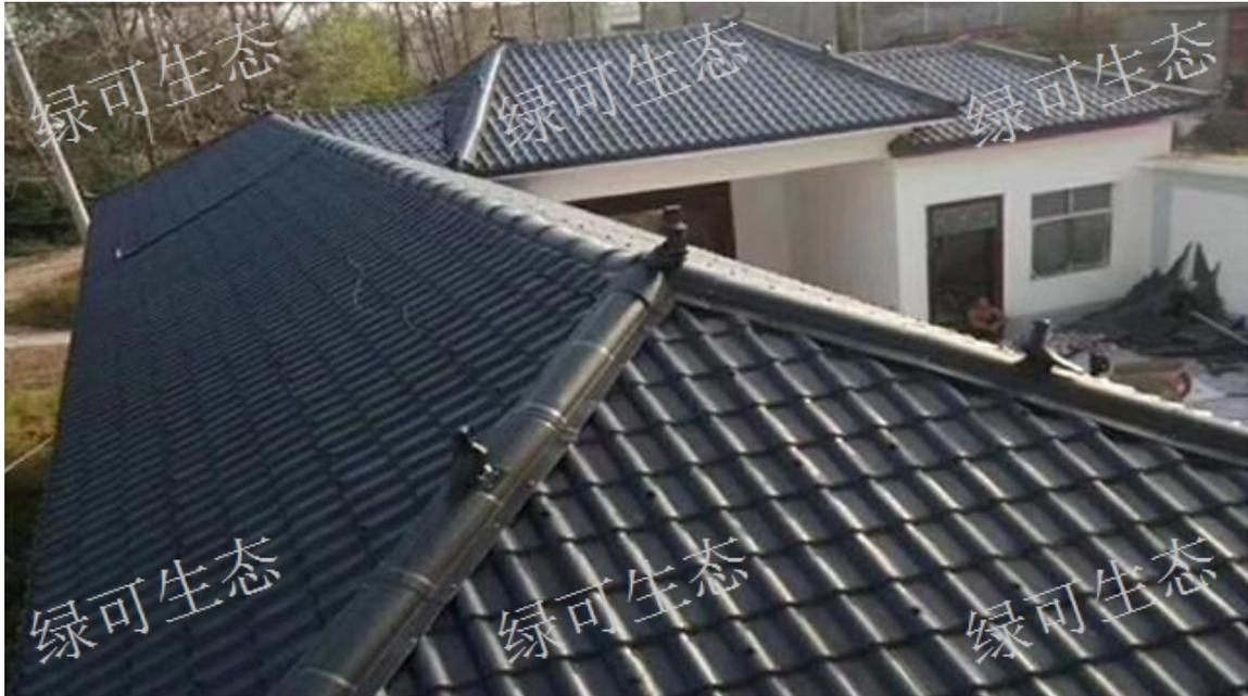
树脂瓦多少钱一平方？好的树脂瓦表层是ASA耐候工程树脂，且厚度达国家标准规定的0.15mm□这样的瓦材品质、性能、使用寿命都非常优越，当然，原材料用的好，价格自然也会贵很多，价格永远是围着价值转的。市场上也有便宜的树脂瓦，原材料的使用跟质量树脂瓦肯定就不一样，有的ASA面层厚度达不到0.15mm□有的甚至使用ABS来代替ASA□这样的瓦材易褪色、易断裂、不抗老化、使用寿命短，虚有树脂瓦的外形而无其实质功能。所以，建议大家在采购时不要贪图一时之利，而给自己带来更大的麻烦和损失。
